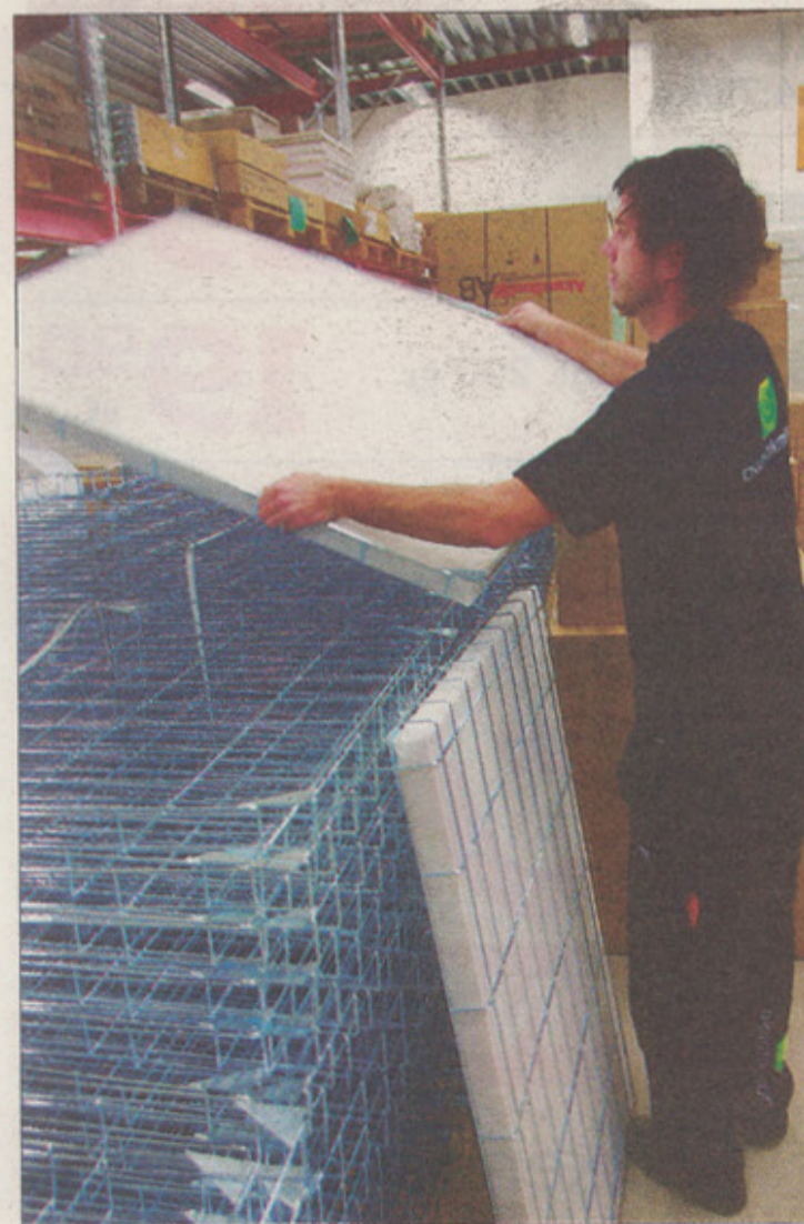
SPORTABSORBENT. Så kallas de här ståltrådsklädda sakerna som många nog sett i taket av idrottshallar. Andreas Johansson heter han som monterar.
